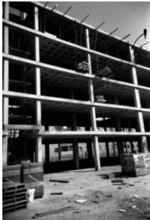
Foto 6.3 Detalles del edificio de la foto 6.2. Se ve una junta de separación entre módulos.
