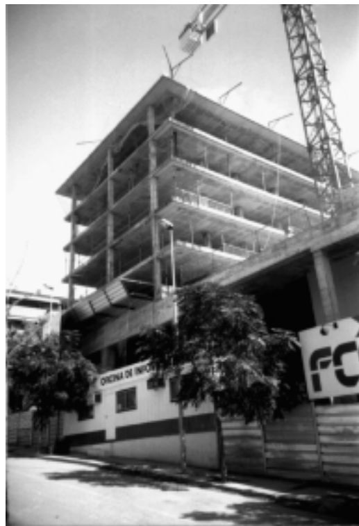
Foto 6.1 Edificio con columnas y forjados reticulares.
