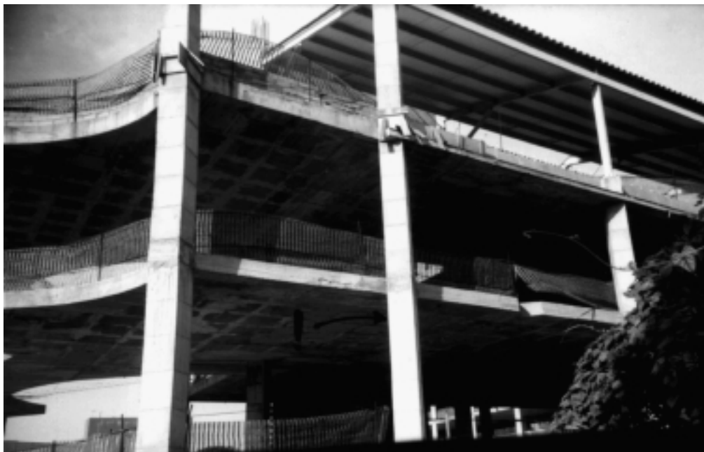
Foto 6.5 Columnas colocadas de manera inadecuada a un diseño sísmorresistente en un edificio con columnnas y forjados reticulares.
